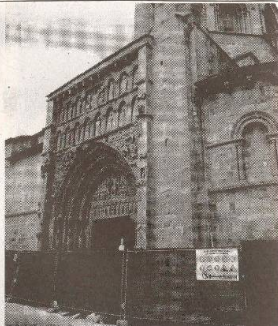
Santa María en obras.
