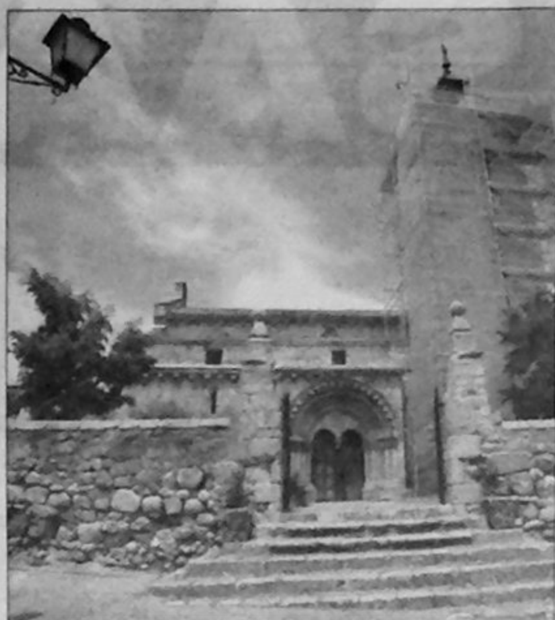
Caltojar, donde su estado de deterioro obligó a hacer obras de rehabilitación. / D. S.
